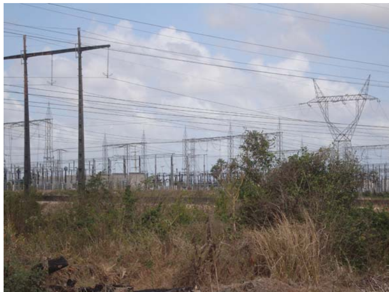
Conjunto adensado de linhas de transmissão da CHESF e da COELCE.
