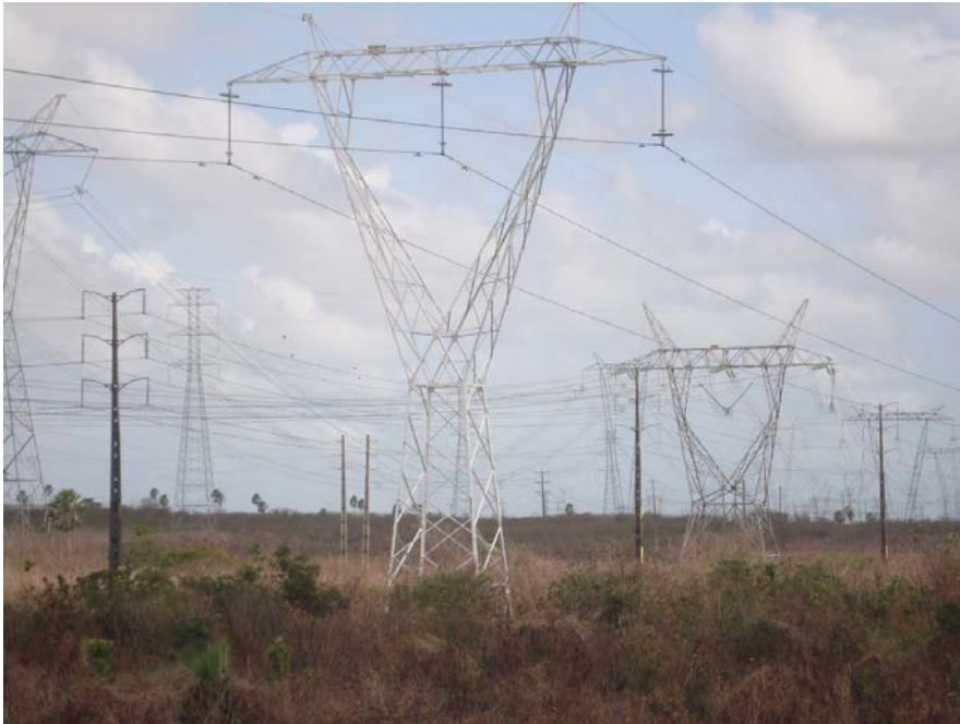
Torres de linhas de transmissão da CHESF.
